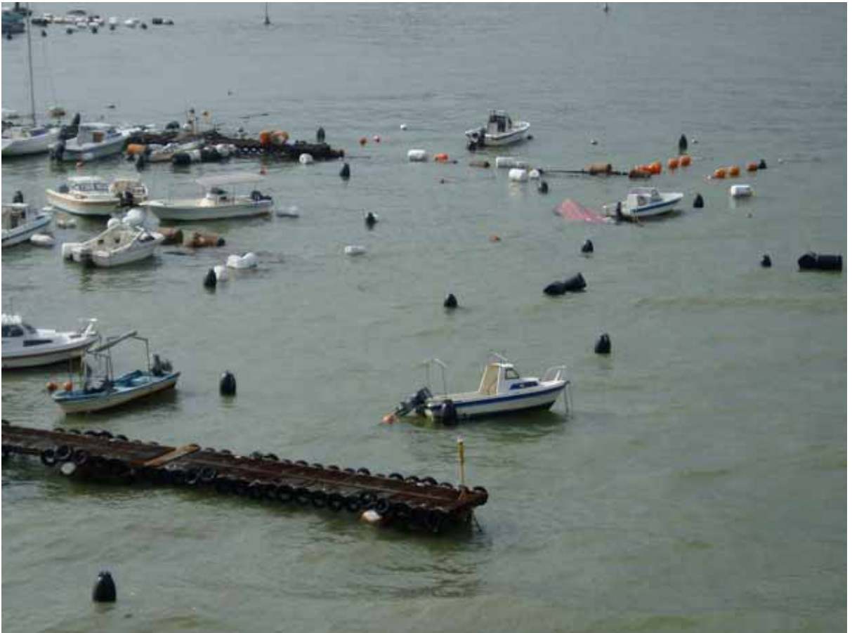
港の入り口近くの暫定桟橋では、長い3本の桟橋のうち2本が沈没し、繫留されていた船は、流失や転覆している。
